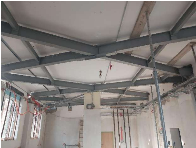
Slika 4: Primer branaste jeklene konstrukcije
