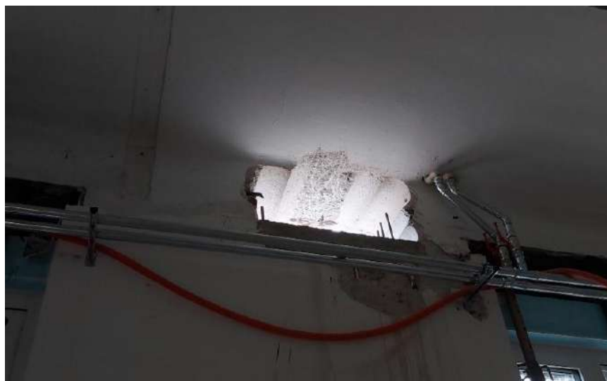
Slika 5: Priprava ležišča za branasto konstrukcijo
